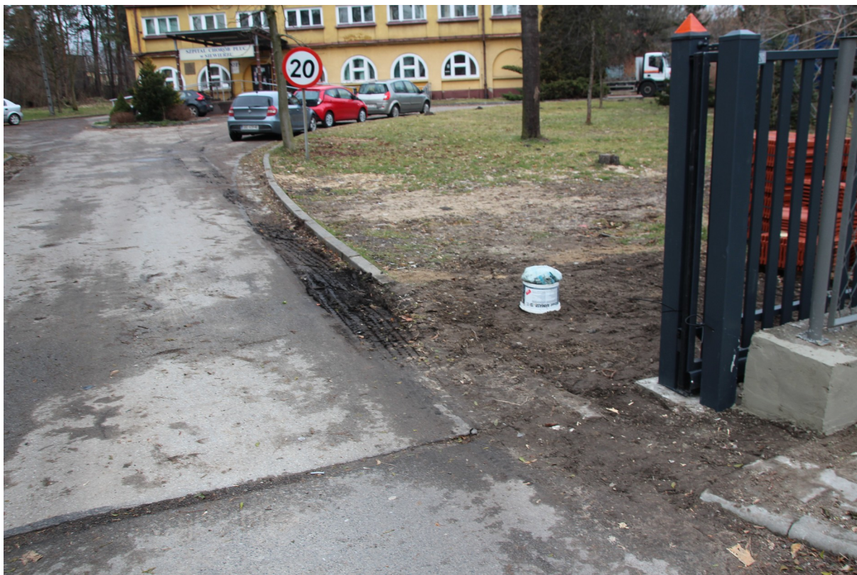
Zdj nr. 1 Główna brama wjazdowa
